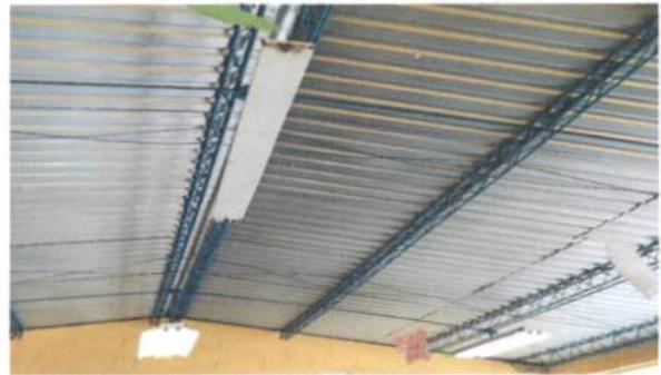
Foto 6: Sustrucción de lámparas 2x40 por focos ahorradoras. Y cambio de cableado eléctrico.
